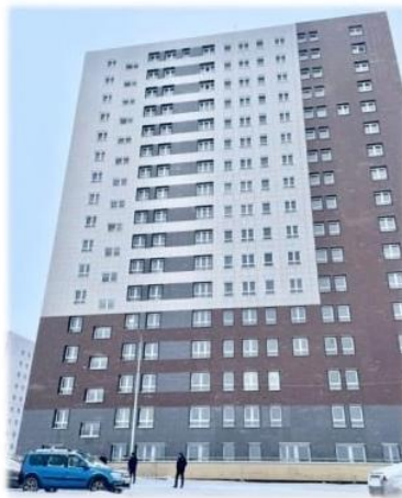
МКД по адресу: г. Киров, ул. Капитана Дорофеева, д.16
